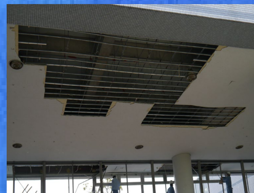
外装材被害事例
