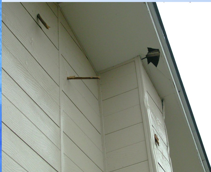
竜巻により木材が飛来物として外壁に貫入 (2004年北海道厚賀)
