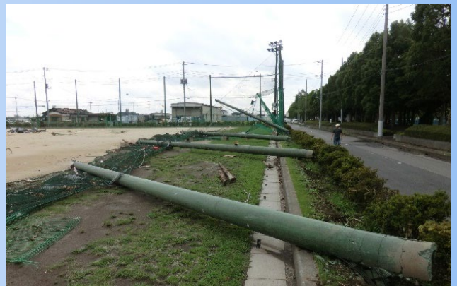
埼玉県越谷市の竜巻被害 2013年
