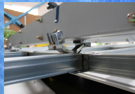
軒天井の破壊の様子
