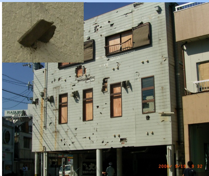
竜巻により屋根ふき材が飛来物として外壁に衝突 (2006年 宮崎県延岡市)
